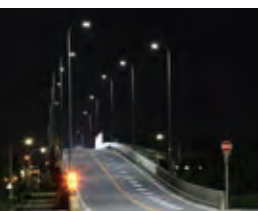
■道路照明器具
