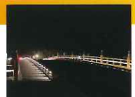
LED歩道照明
