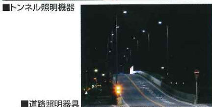
■道路照明器具
